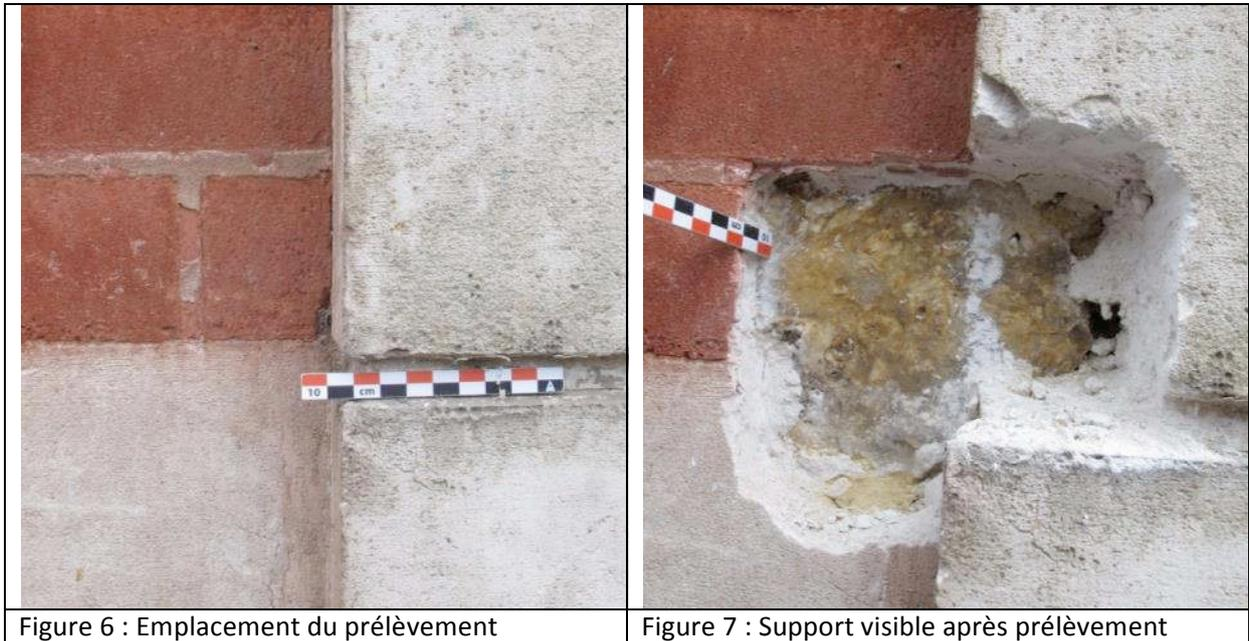
L'enduit fait 2 cm d'épaisseur, constitué de deux couches avec deux finitions différentes (Figure ) :
